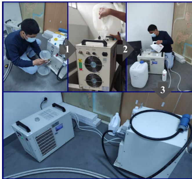
Figura 28. Limpieza y carga de líquido refrigerante en las zonas del sistema de enfriamiento chiller.
