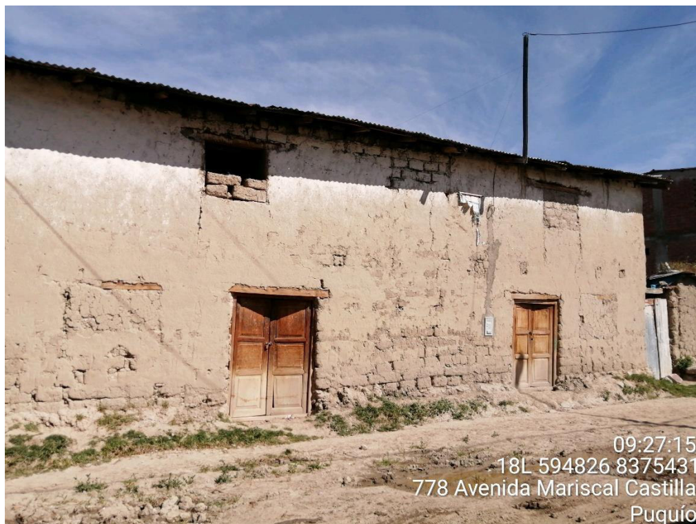
Fotografía 3. Vivienda del Barrio de Ccollana
