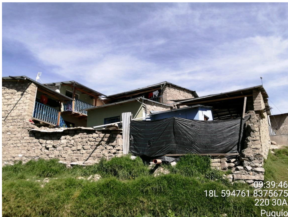
Fotografía 6. Vivienda del Barrio de Ccollana
