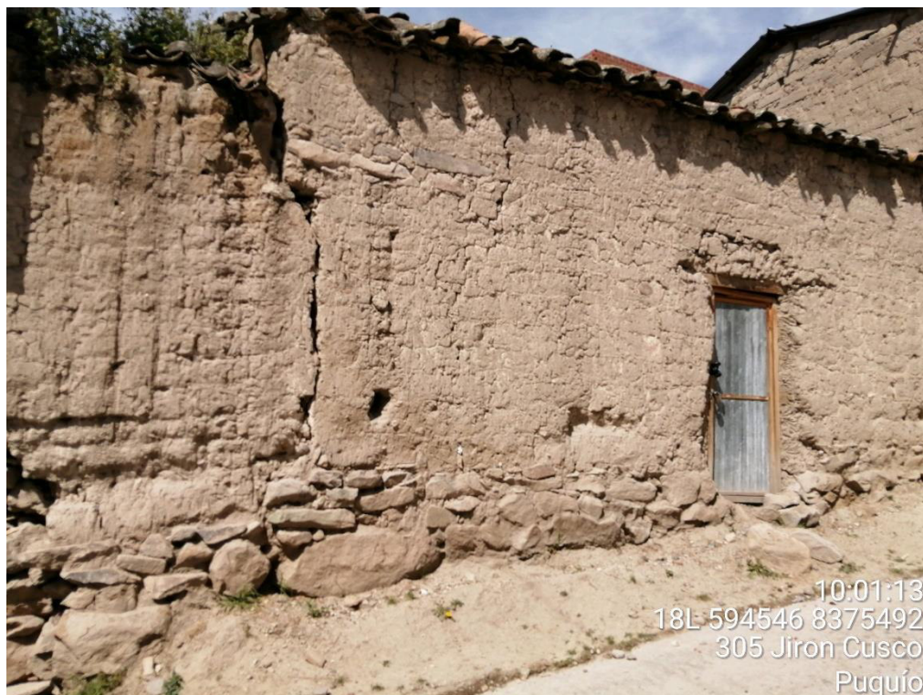
Fotografía 5. Vivienda del Barrio de Ccollana
