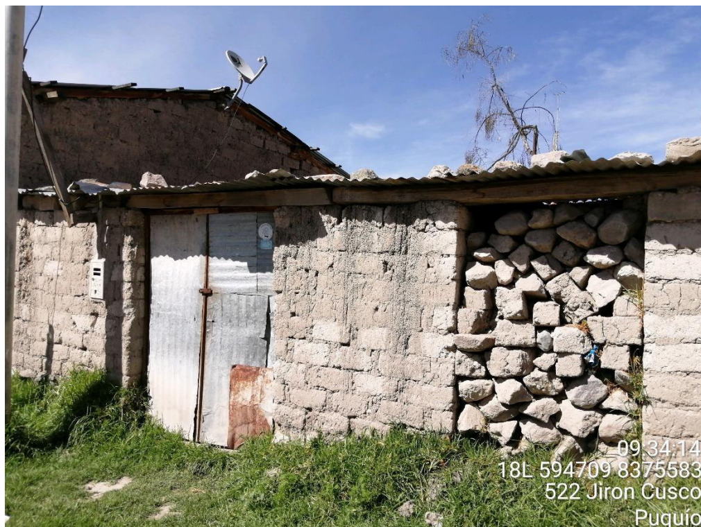
Fotografía 4. Vivienda del Barrio de Ccollana
