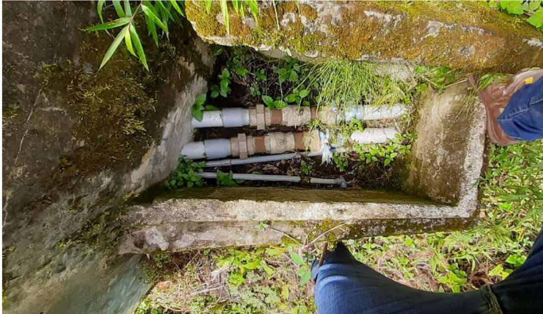
Fotografía 6. En la siguiente fotografía se puede observar la caja de válvulas de la captación pachachaca, las válvulas oxidadas y dos tuberías de 2" de diámetro que abastecen deficientemente al centro poblado Cadmalca Bajo, también se puede apreciar dos tuberías de menor diámetro que salen de la cámara húmeda que de forma clandestina algunas personas lo instalaron para riego de sus chacras
