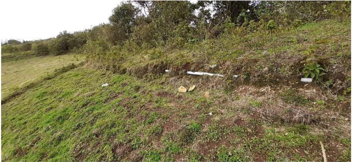
Fotografía 12. En la fotografía se puede apreciar la línea de conducción expuesta a causa de la constante erosión de la ladera por donde pasa
