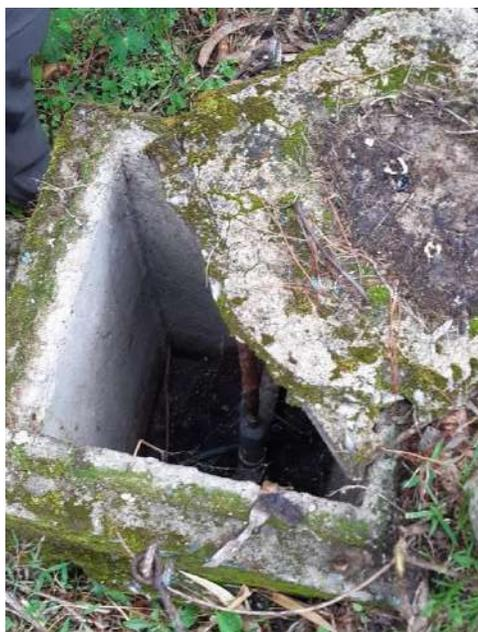
Fotografía 15. En la siguiente fotografía se puede apreciar el estado deteriorado de la caja de concreto de la válvula de aire.
