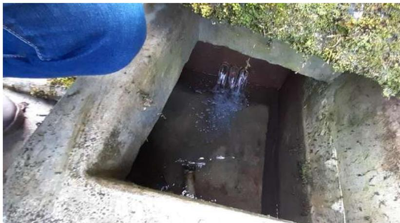
Fotografía 5. Se puede apreciar el interior de la captación Pachachaca y sus 3 orificios “llorones” por donde ingresa el agua a la cámara húmeda presentando abundante caudal
