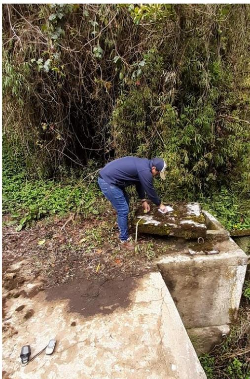
Fotografía 4. Captación Pachachaca deteriorado, con bastante vegetación y tapa de concreto.
