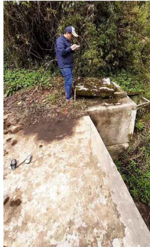
Fotografía 4. Se observa la verificación del estado situacional de la captación Pachachaca cubierto de maleza y deteriorado por la antigüedad; además no cuenta con un cerco perimétrico para evitar el ingreso de personas inescrupulosas.
