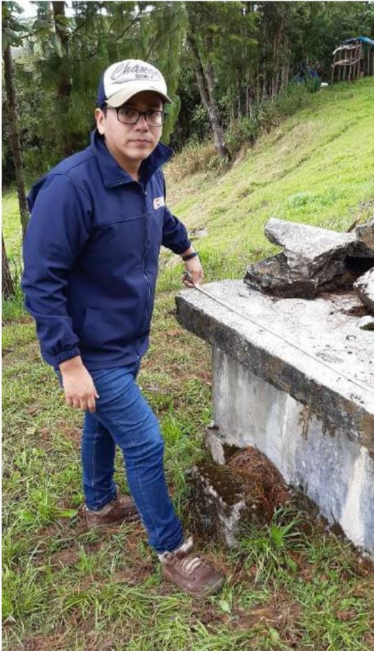
Fotografía 13. En la fotografía se puede observar una cámara rompe presión existente y la situación en la que se encuentra es deteriorada con la tapa de cemento destruida
