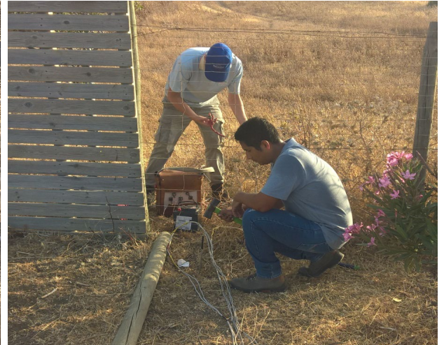
Figura 3.3: Conexión entre el electrodo y el cable multiconductor.
