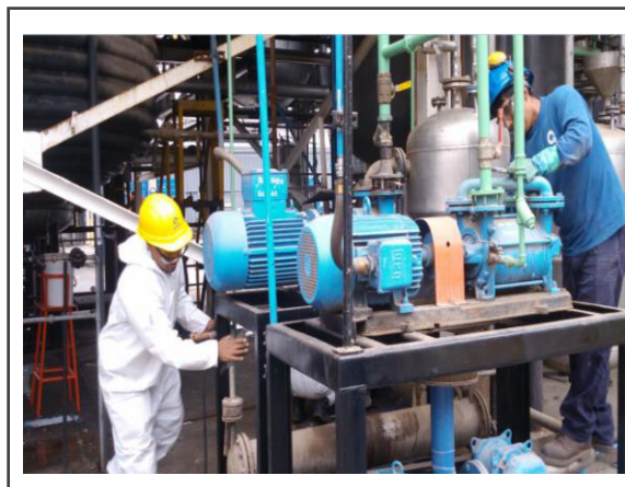
Figura 31. Ejecución del mantenimiento
