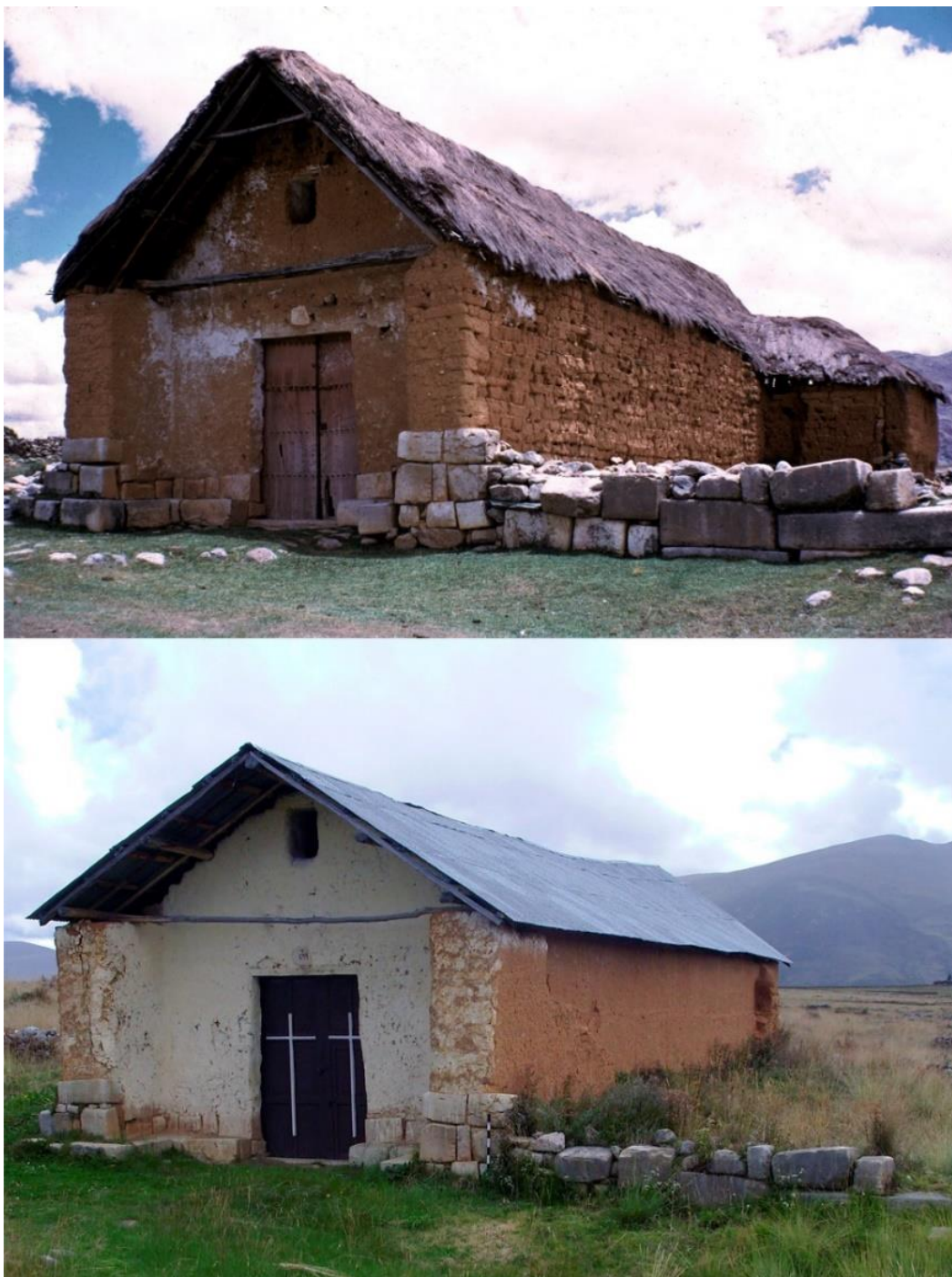
Figura 62. Capilla Virgen Purísima en diferentes épocas. Nótese las bases de la fachada construida con piedras incas talladas reutilizadas (foto superior: Barash, 1965; foto inferior: Ordóñez, 2012).
