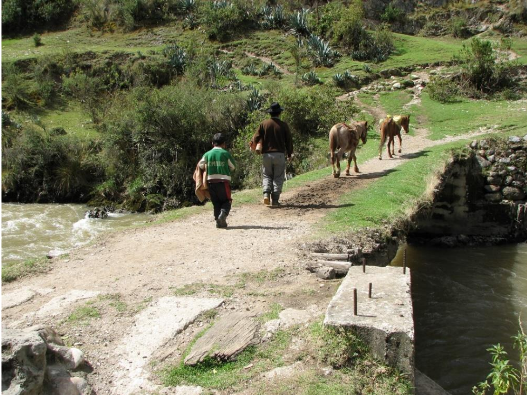
Figura 24. Vista actual del puente de Colpa. Aunque se continuaron utilizando troncos y chaklas para su reconstrucción, las bases del puente ahora son de fierro y concreto (Ordóñez, 2007).
