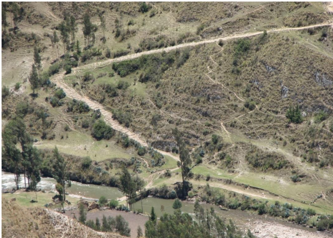
Figura 23. Al norte de Huánuco Pampa el qhapaq ñan zigzagueante asciende hacia las alturas de San Lorenzo de Pachas, en la parte inferior el actual puente de Colpa sobre el río Vizcarra (Ordóñez, 2007).
