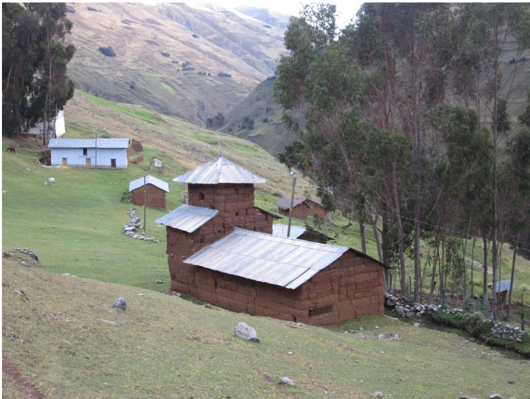
Figura 12. Capilla de Estanque. Nótese sus muros contruidos con tapiales y el techo de calamina (Castro, 2018).
