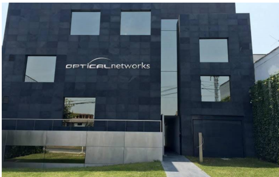
FIGURA 7: SEDE DE LA GERENCIA COMERCIAL DE OPTICAL NETWORKS (Fuente: Optical networks).
