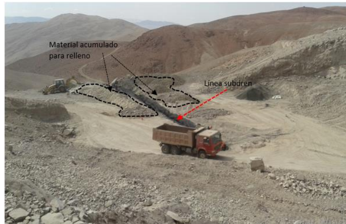
Foto N°45: Trabajos en subdren, donde se está cubriendo con geotextil envolviendo el filtro, se procede a cubrir el dren con canto rodado.
