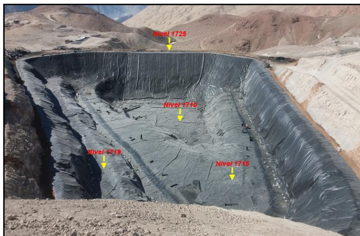
Fig 42.- Vista del vaso de presa impermeabilizado.
