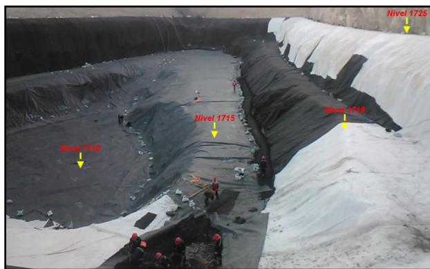
Fig 41.- Vista de la impermeabilización del vaso de presa con Geotextil 420g/m2, GCL (membrana de arcilla), geomembrana 1.5 y 2 mm de espesor.
