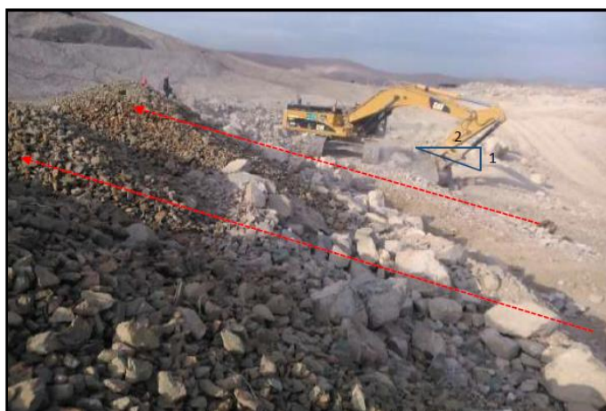
Fig 36.- Control topográfico del talud aguas debajo del dique de arranque de 1V/2H.
