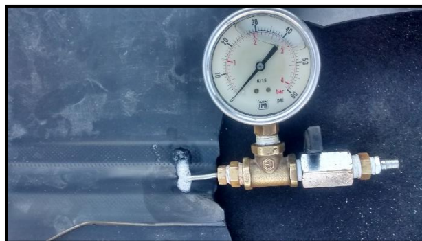
Fig 48.- Control de calidad de soldadura por fusión.
