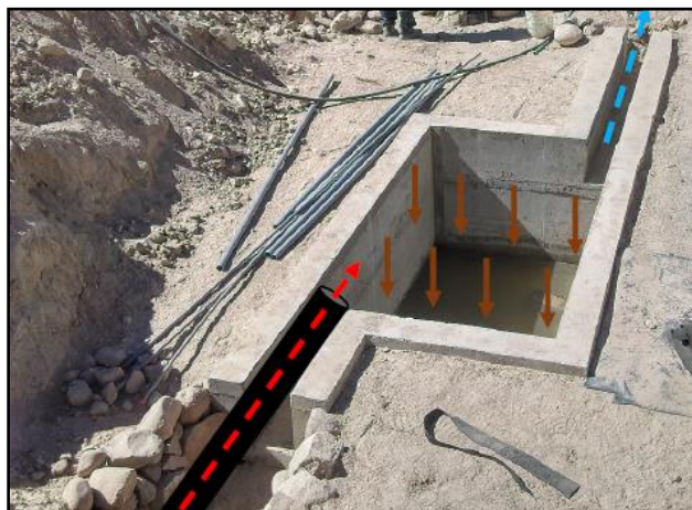
Fig 39.- Poza de sedimentación de finos
