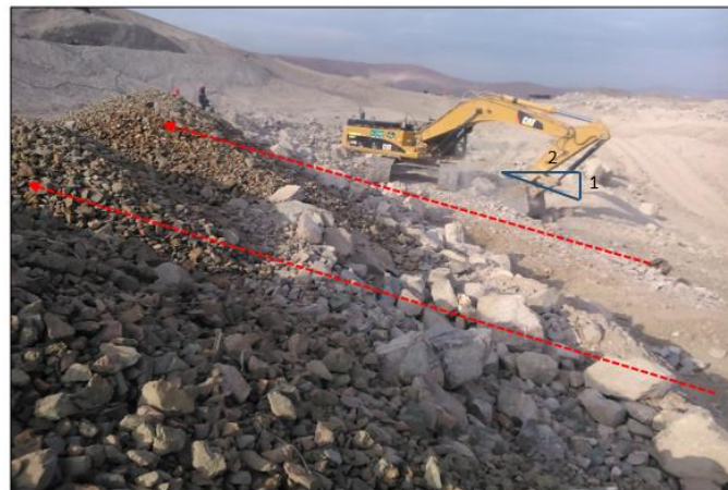
Foto N°57: Perfilado de talud externo (2H/1V) e interno (1H/1V) de dique de arranque con excavadora CAT 329D y excavadora DOOSAN.
