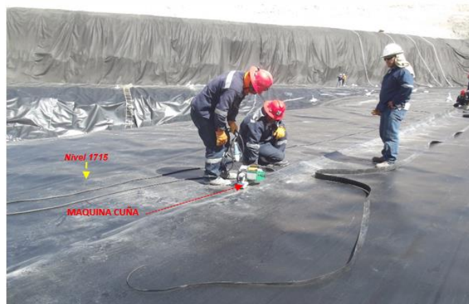
Foto N°103: Soldadura por Cuña, utilizada para unir dos paños de geomembrana y que tiene como respectivos ensayos de tensión y la prueba de aire.
