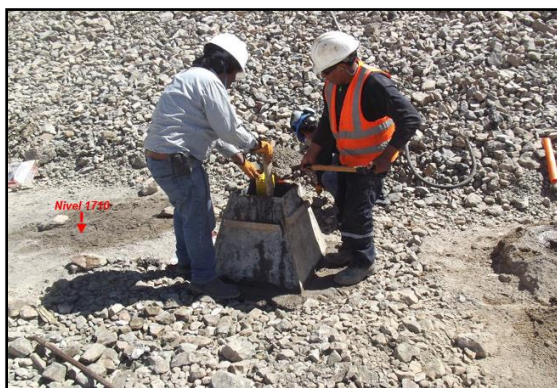
Fig 43.- Instalación de piezómetro 02, en el dique de arranque a vota 1710.
