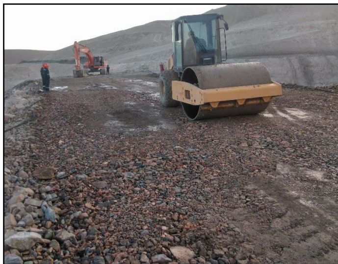
Fig 25.- Vista del dique de arranque en su cota 1723 en compactación, haciendo 8 ciclos (resultado de los ensayos de asentamiento).
