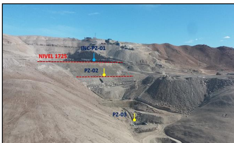
Fig 44.- Vista de piezómetros e Inclinómetro de la presa de relaves.
