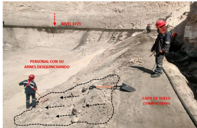
Foto N°88: Se procede con el acondicionamiento del terreno, desquince, limpieza de banquetas y taludes por parte del personal. Despunte y limpieza del talud 1719 a 1725 msnm, lado Este del vaso.
