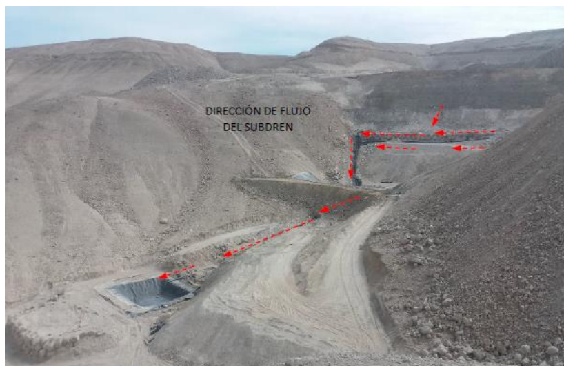
Fig 35.- Sistema de subdrenaje en el área de recrecimiento de la presa de relaves, poza de sedimentación y poza colectora final.
