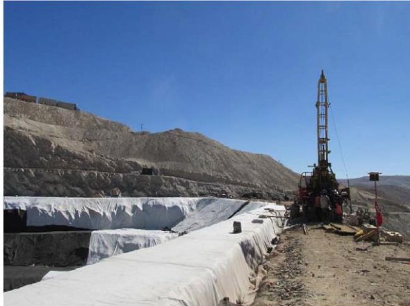
Foto n°01: Perforación del Piezómetro – Inclínometro PZ-IN - 01, perforadora Ly-38.
