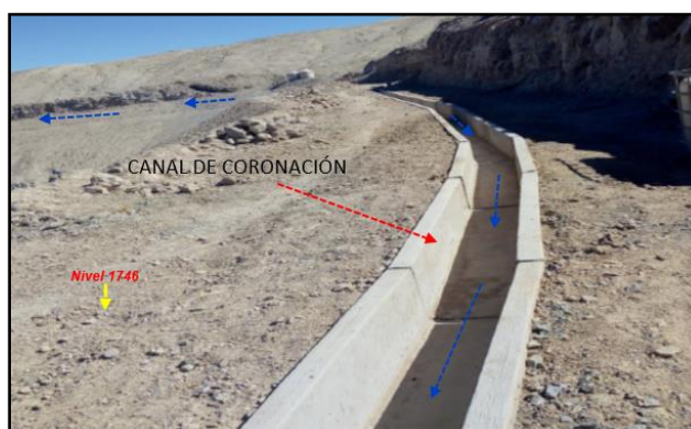
Fig 46.- Canal de coronación, vista Este a Oeste.
