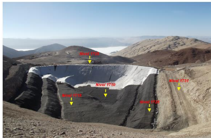
Foto N°97: Vista panorámica del vaso sector Sur, recubrimiento de taludes con geotextil en un 100% y recubrimiento con GCL en un 100%, a espera de los equipos de soldadura de geomembrana.
