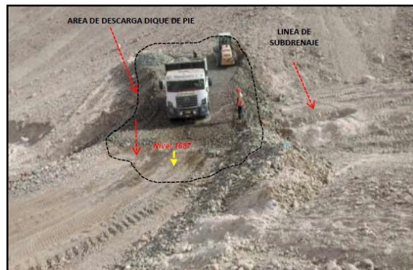
Fig 38.- Movimiento de desmonte al dique de pie.
