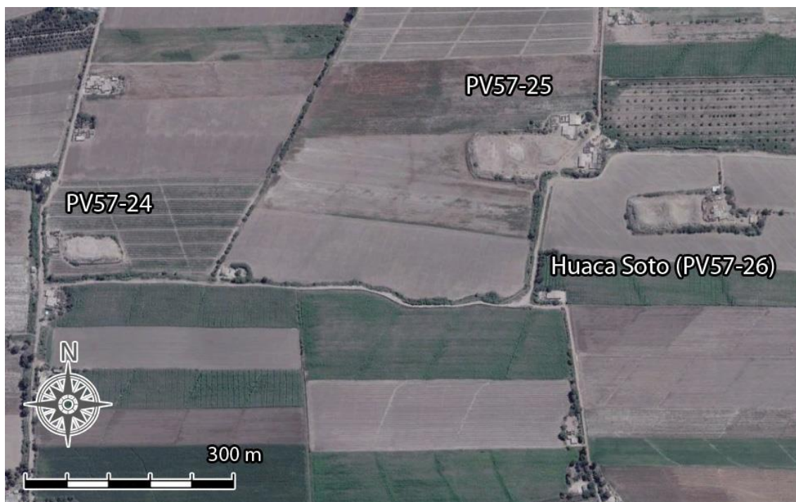
Figura 9. Vista satelital del complejo Soto. Se observa el sitio excavado de Huaca Soto (PV57-26).
