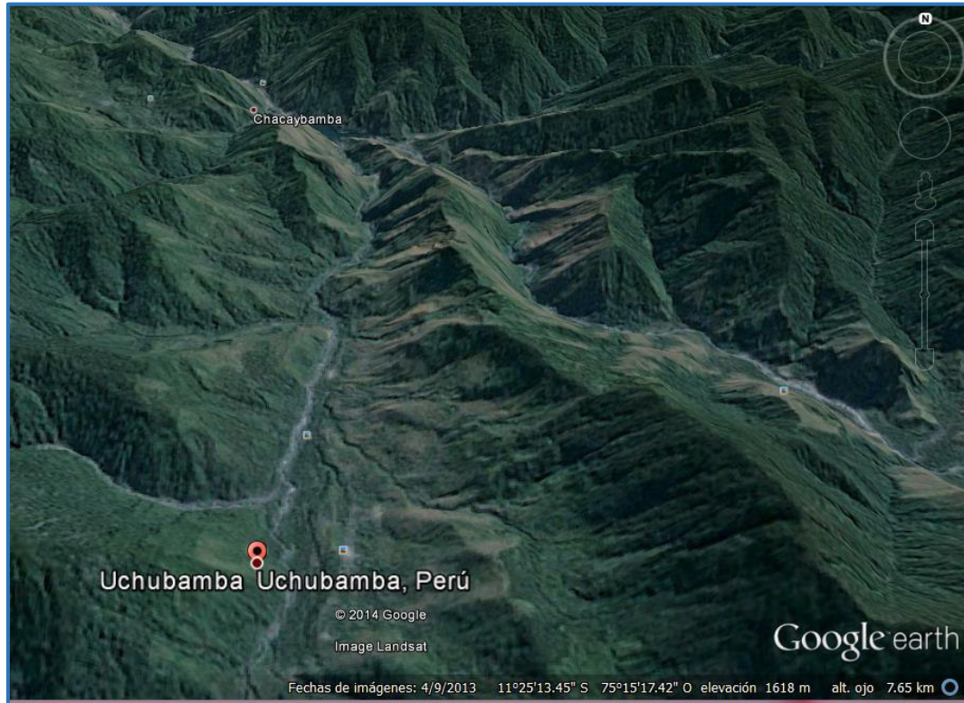
Figura N° 05. Imagen Satelital de las Comunidades: San Juan de Uchubamba y San José de Villano
