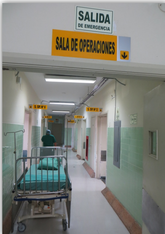
Fig. 39 Sala de Operaciones.
