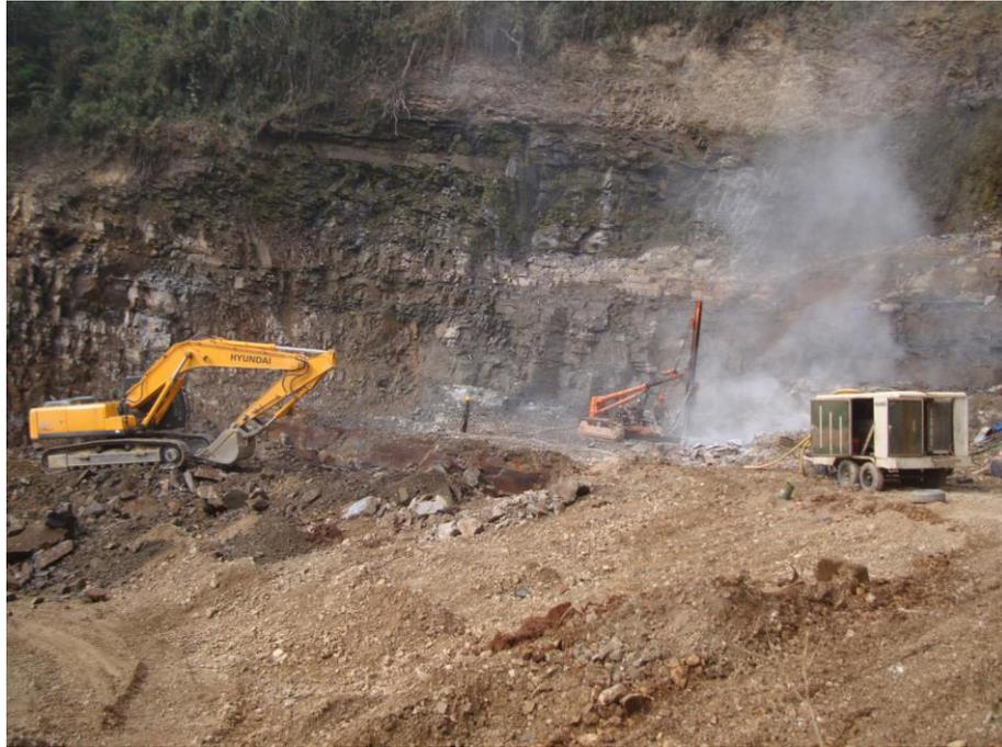
*Figura 15: Perforación mecanizada en la progresiva km 1+380, con compresora neumática 750 pcm, roca arenisca. Fuente. Propia*
