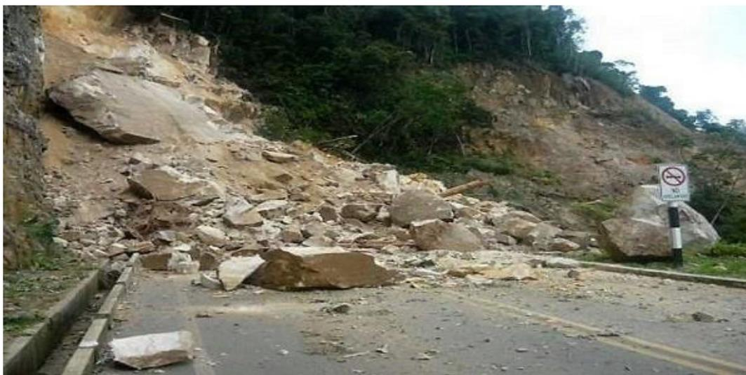
*Figura 6: Falla de talud, Guadalquivir. Fuente: Diario Navarra-España.*
