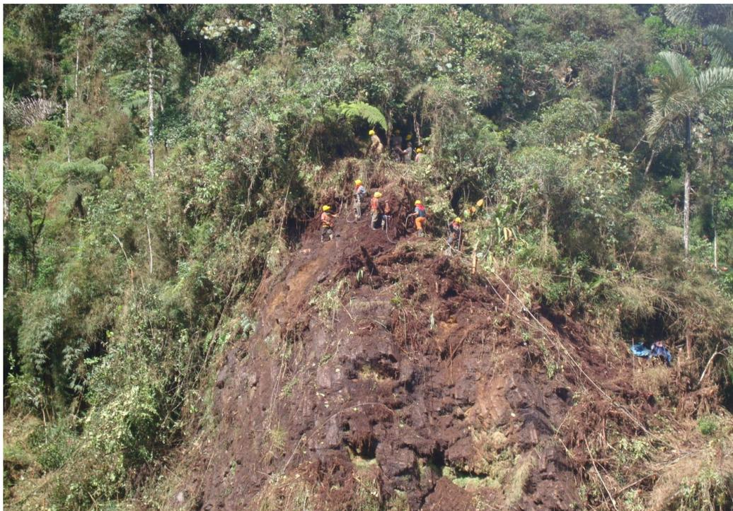
*Figura 14: Perforación manual con martillos neumáticos en la progresiva km 3+280 en la cresta del talud roca limolita. Fuente. Propia*
