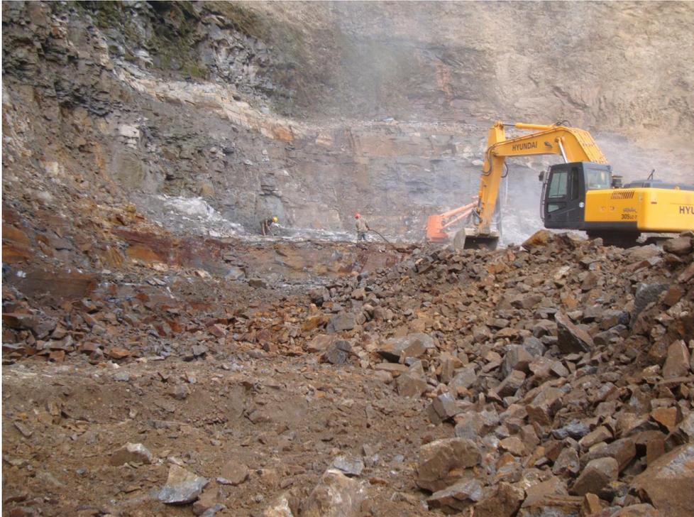
*Figura 18: Limpieza de material con fragmentación apropiada después de la voladura, con factor de carga 0.3 kg/m<sup>3</sup>, en la progresiva km 1+380 (doble banqueo de talud) roca limolita y arenisca. Fuente. Propia.*
