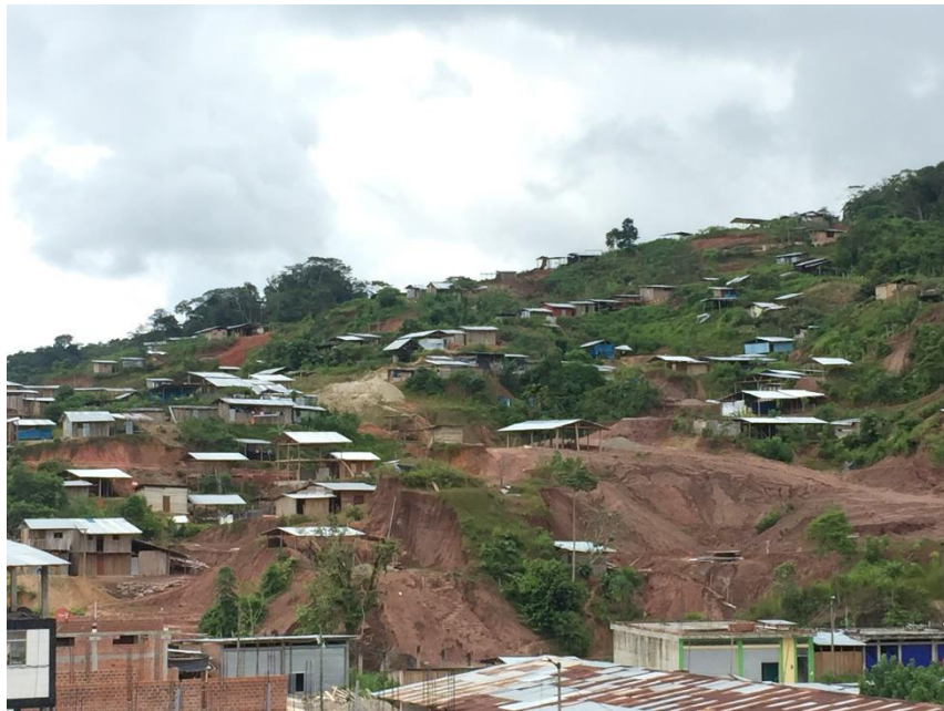
Imagen del barrio Cinco de Junio, ubicado en el pueblo Chiriaco Fuente: foto propia
